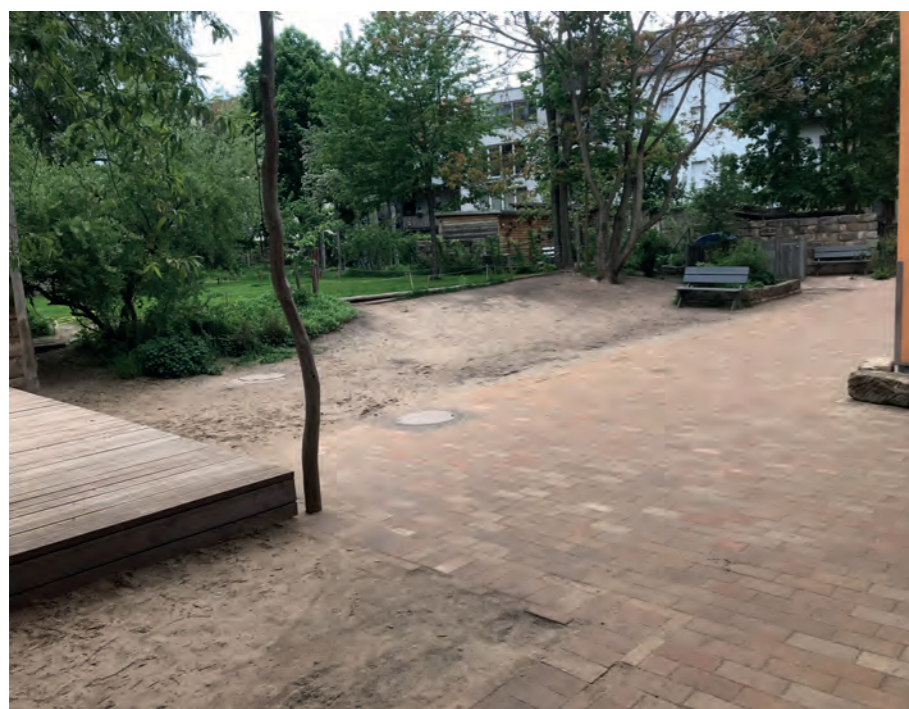
Hanglage mit Regenwasserproblem
